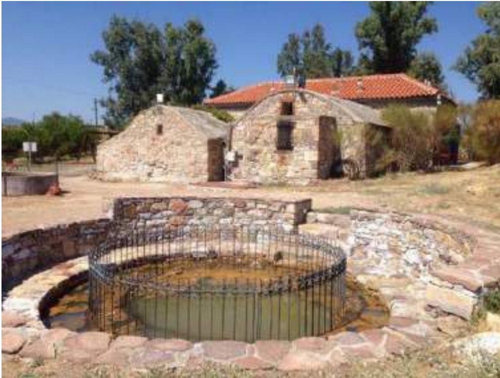
Ακίνητο Β, εξωτερικός χώρος με θερμά νερά, ΝΔ όψη εγκαταστάσεων
