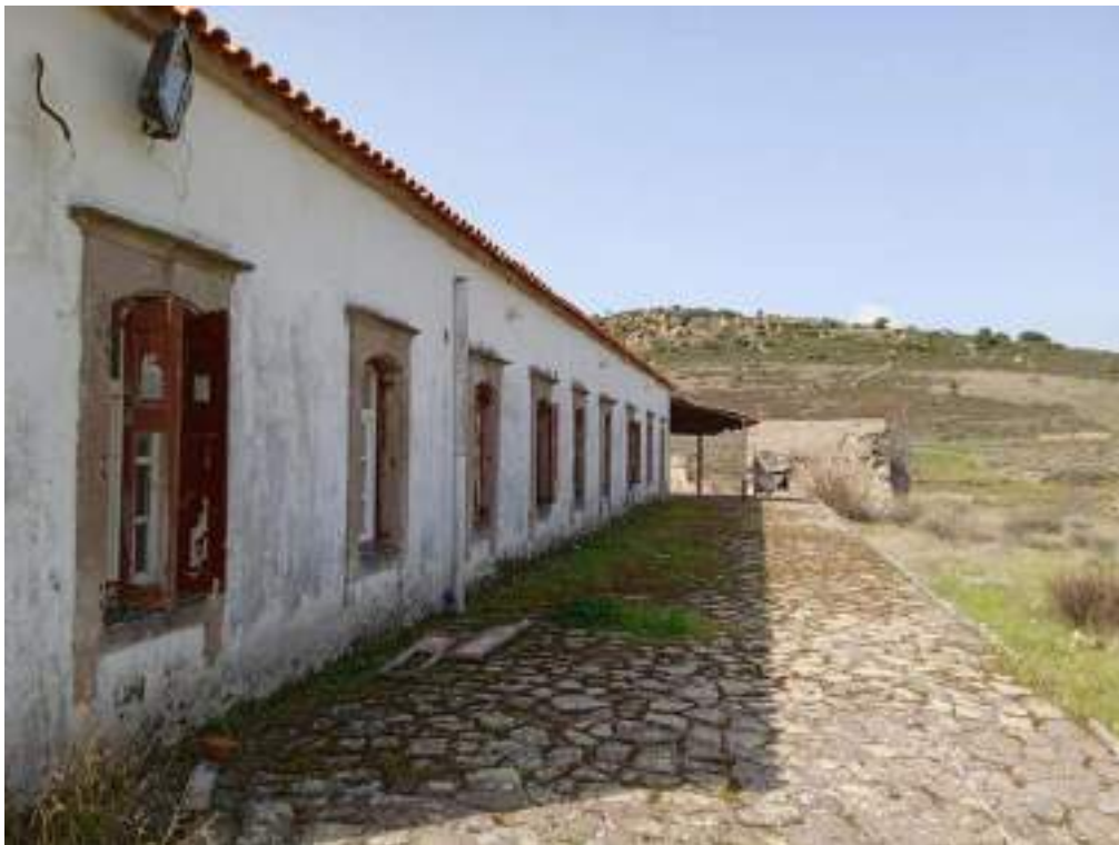
Ακίνητο Α, ξενώνας, Β όψη
