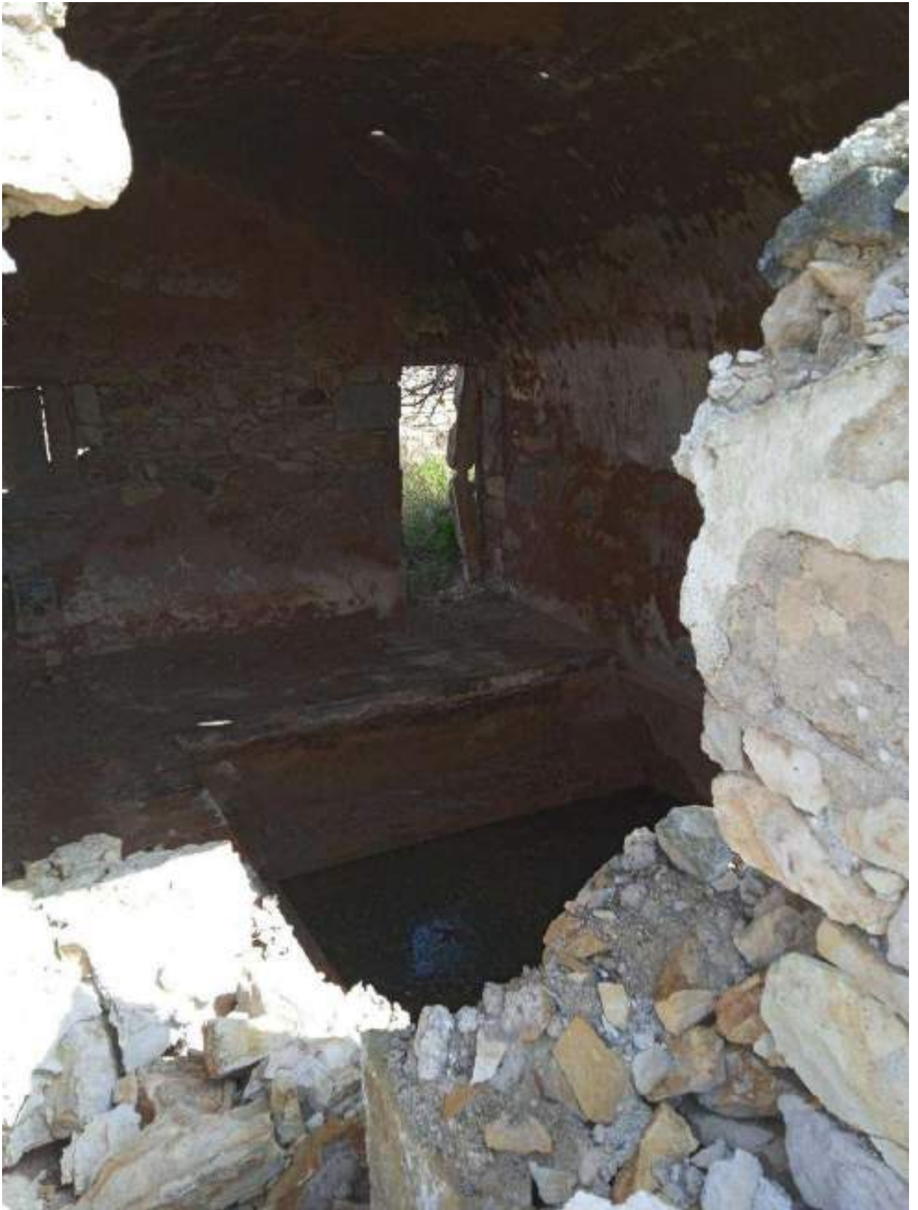
Ακίνητο Α, εσωτερικό λουτρού β
