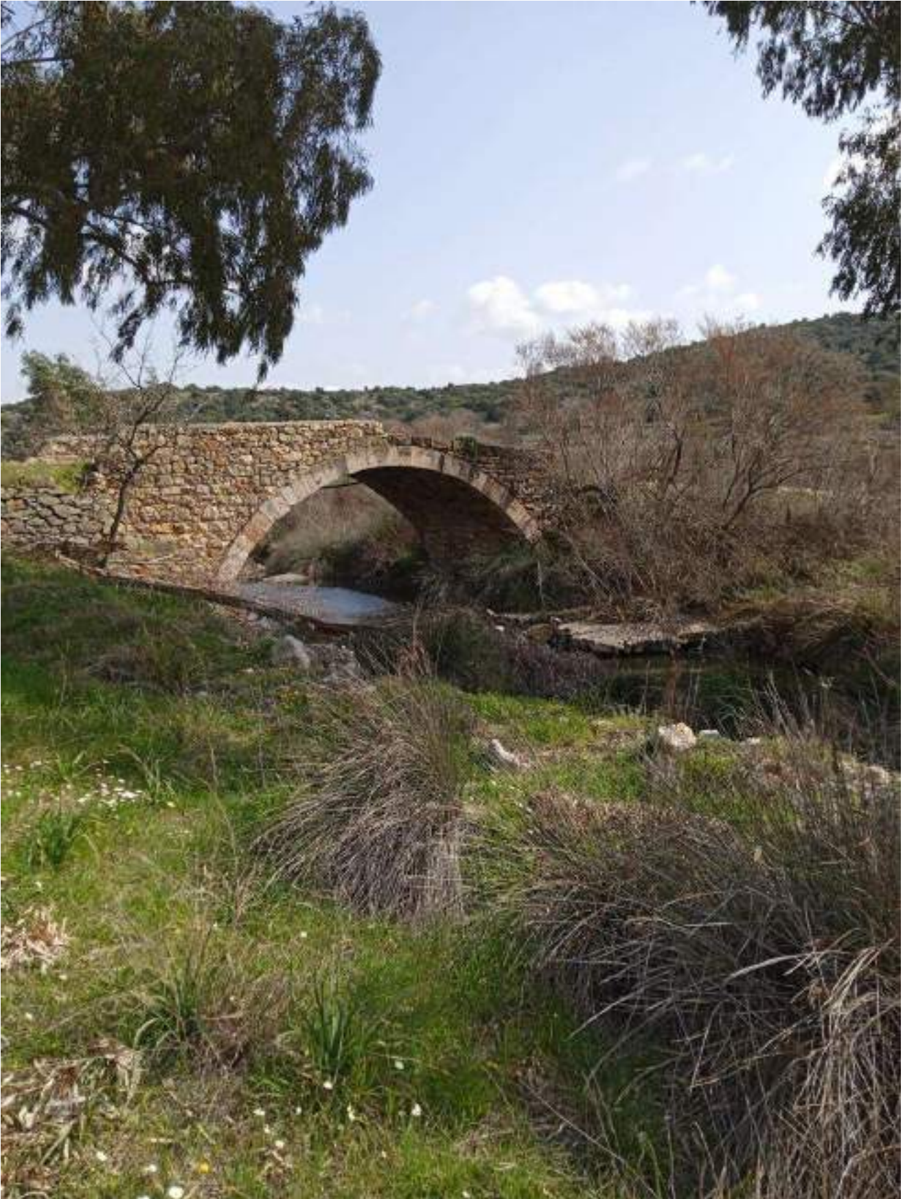
Πετρόχτιστο μονότοξο γεφύρι στο δρόμο μεταξύ των ακινήτων Α και Β
