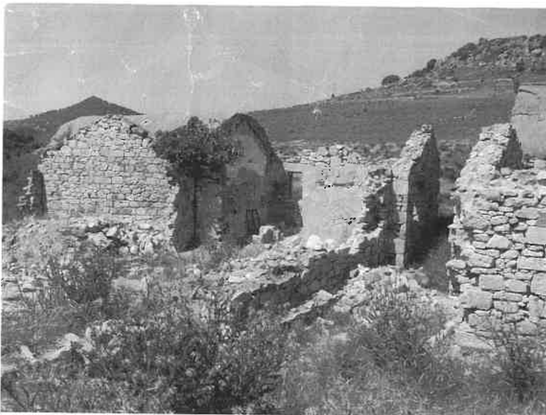
Ακίνητο Α, ερείπια κτισμάτων
